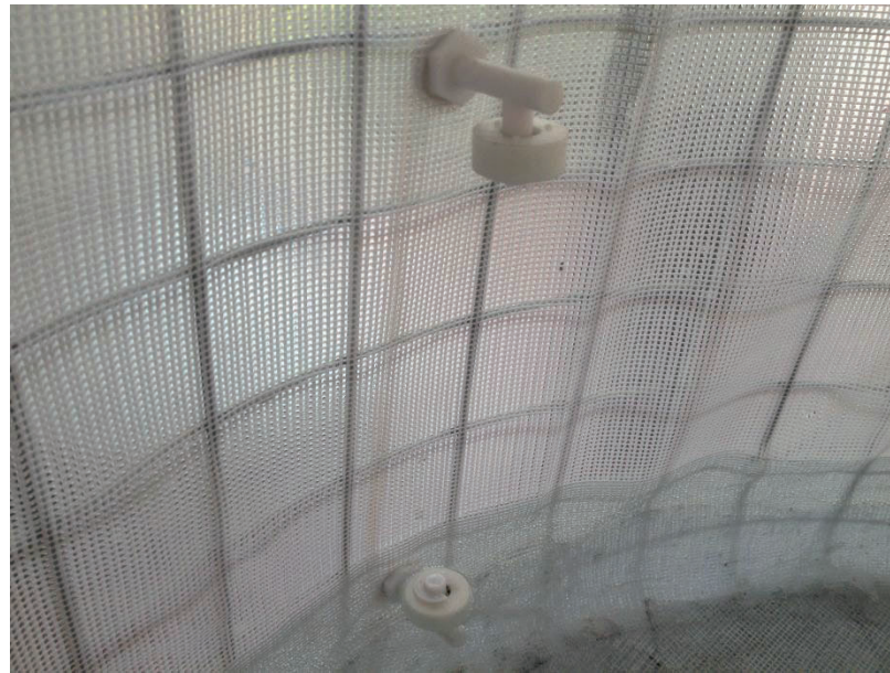
Imagen 4.20 Sensor de seguridad o de nivel mínimo.
