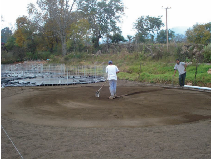
Imagen 4.7 Construcción de los estanques.
