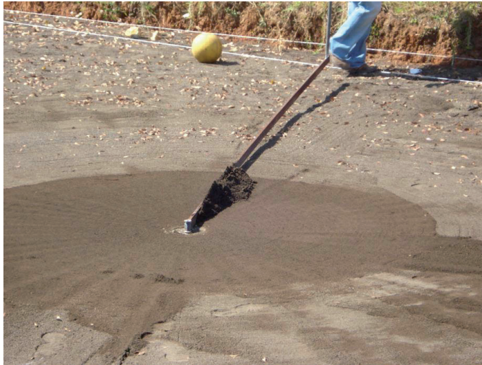
Imagen 4.5 Preparación cónica de la base de los estanques.
