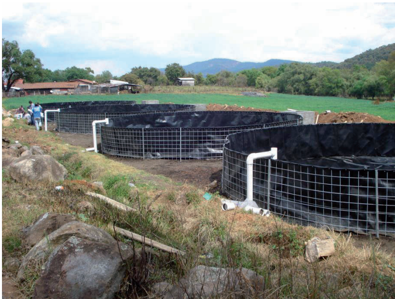
Imagen 4.8 Estanques de geomembrana terminados.
