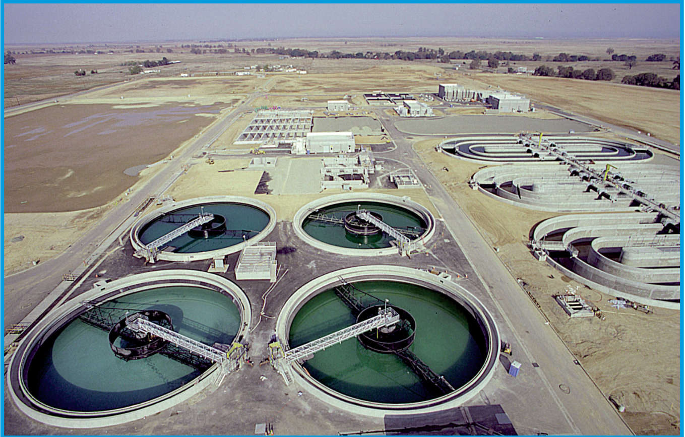
PLANTA DE TRATAMIENTO DE AGUAS RESIDUALES "BIOREACTOR DE MEMBRANA VERDE LG" http://tecnorevista.com/wp-content/uploads/2010/11/planta-tratamiento-aguas.jpg
