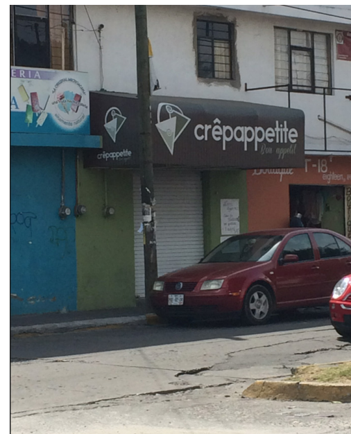
Figura 18. Vista del local desde el exterior.
