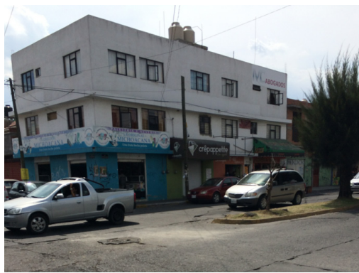
Figura 17. Vista del edificio donde se encuentra el local.
