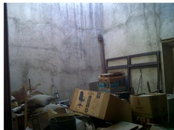
a. interior habitación 3 vista sur-poriente.
