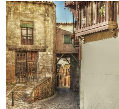
Ilustración 15 Antiguo cobertizo, calle Doncellas, Toledo, España.
