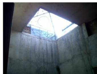
b. interior de la habitación, vista hacia el domo.
