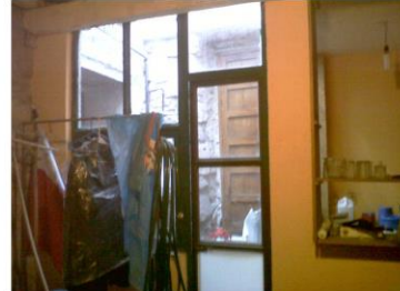
d. interior de habitación 1, vista hacia el área en donde se encuentra un boiler y tanque de gas LP, cubo de luz.
