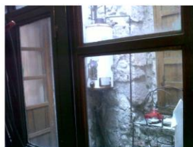
Detalle: Vista hacia un "patio" que se puede ver desde el ventanal de la planta baja y alta de la habitación 1, aquí se encuentra un boiler y la puerta de madera que esta hacia la izquierda se tiene vista hacia el baño de la habitación 2.
