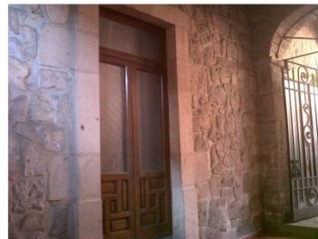
c. acceso hacia un espacio en construcción.
