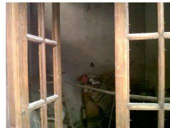
16.a.vista hacia el interior del espacio contiguo al anterior y a las escaleras que se encuentran en lado oriente.
