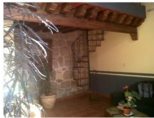
a. Espacio en general de la sala de espera actual, escaleras que dirigen hacia el mezzanine.
