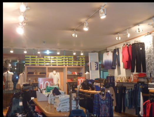
FIG 121. ILUMINACIÓN INCANDESCENTE SOBRE RIEL AL INTERIOR DE "LOB"
