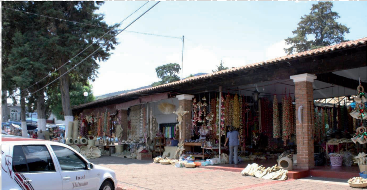
Imagen 058.- FACHADA PRINCIPAL [orientación sureste]
