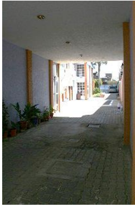
Figura 37. Estacionamiento, Vista desde el acceso
