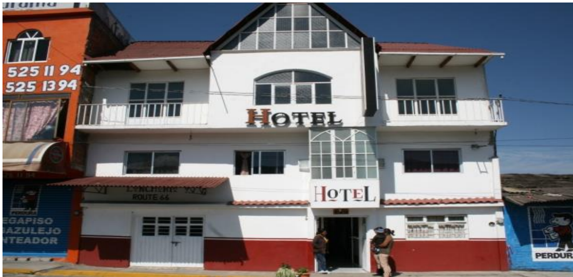
Figura 3. Fachada Hotel "La Misión"
