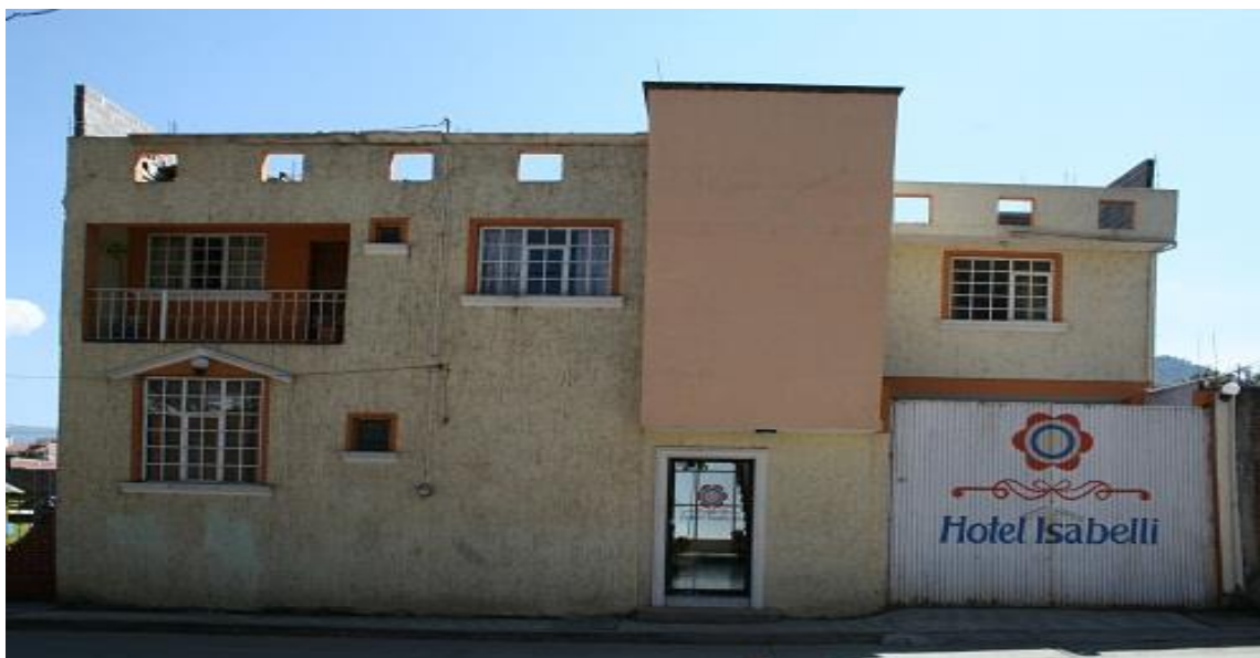
Figura 34. Fachada Hotel Isabelli
