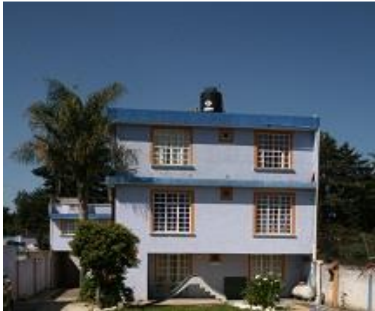
Figura 35. Fachada Interior. Vista desde el Jardín.
