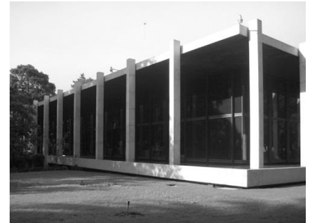
Imagen 3, Edificio del CAPCE, http://www.arquine.com/francisco-artigas-y-el-capfce/ , consultado septiembre 2015.
