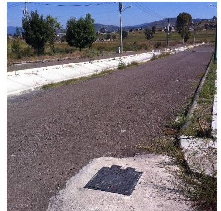
Imagen 50, Registro de Agua Potable, tomada octubre 2015
