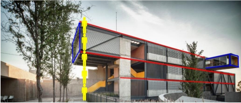
Imagen 30, Colegio Harvest, elaboración propia con imagen obtenida de http://www.archdaily.mx/mx/02-307248/colegio-harvest-zendejas-arquitectos-marvan-arquitectos-martinez-arquitecto , consultado septiembre 2015.
