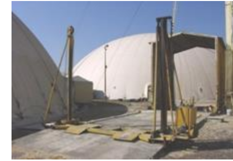
IMAGEN 29. Elevador de camiones manual impulsado por dos brazos hidráulicos de aceite, el cual una vez que el camión se coloca en la plancha de concreto y las llantas frontales quedan sobre las paletas del elevador este sube permitiendo la caída del grano por gravedad hacia la fosa de recepción.
