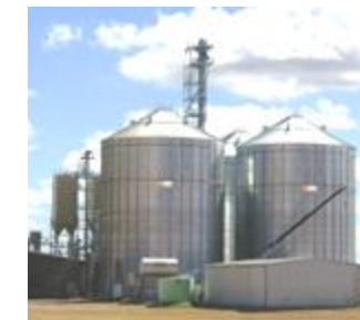
IMAGEN 45. silos con capacidades de 5,000 toneladas o en bodegas de piso plano
