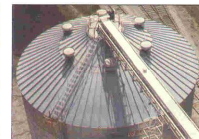
IMAGEN 71 El bastidor del techo de 3.25m. de diámetro sirve para el montaje de transportadores, pasarelas etc. La entrada donde son colocados los conductos 81.28m 2 hace la entrada líneas de suministro de los elevadores.
