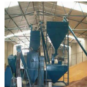
IMAGEN 43. silos con capacidades de 5,000 toneladas o en bodegas de piso plano
