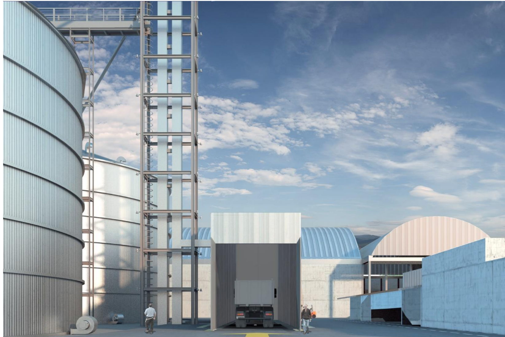
Render 06: Vaciado de camión a Silo primario
