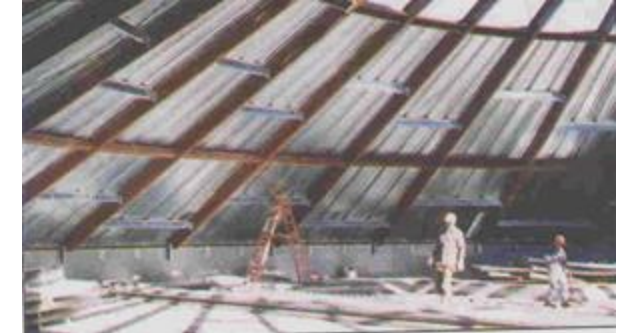
IMAGEN 69 Montaje largueros de compresión pesado
