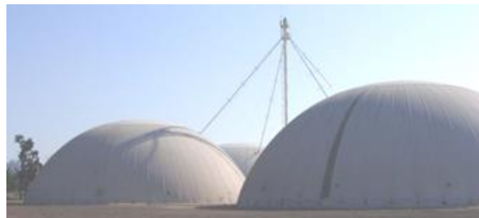
IMAGEN 26. importaron algunas tecnologías de origen brasileño alrededor de los años 70's como fue el caso de los silos "globo", los cuales tenían la capacidad de almacenar hasta 5,000 toneladas de grano
