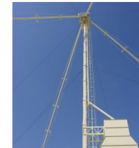
IMAGEN 31. Base a nivel de piso del elevador de grano donde se perciben los dos apoyos: uno por asciende el grano y el otro por donde descienden los cangilones vacios para volver a cargar. 12" ø
