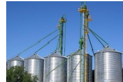
IMAGEN 44. silos con capacidades de 5,000 toneladas o en bodegas de piso plano
