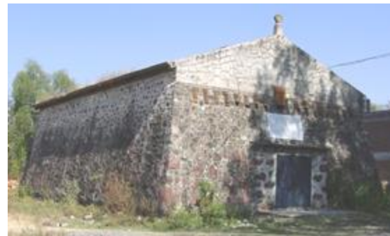
IMAGEN 23. Silos edificados con techumbres elaboradas con vigas de madera, ladrillo de barro o madera. Indaparapeo, Michoacán, México
