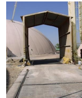
IMAGEN 30. Vista de la distancia que existe para la adecuada colocación de camiones de 15 toneladas.12m
