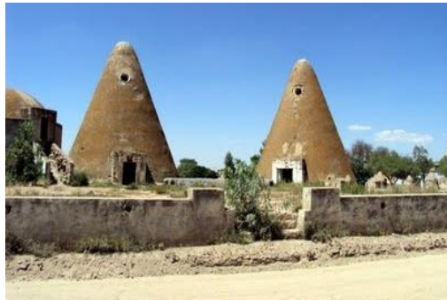
IMAGEN 22. Silos Tipo Cono edificados con tabique de adobe. Hacienda en el Estado de Guanajuato, México.
