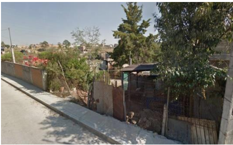
Ilustración no. 78. Viviendas hundidas El Durazno
