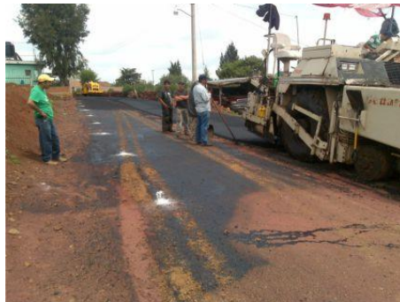
Fig. 4. Construcción de carpeta asfáltica. Fuente: Maquinaria Noriega S.A. de C.V. (2017).
