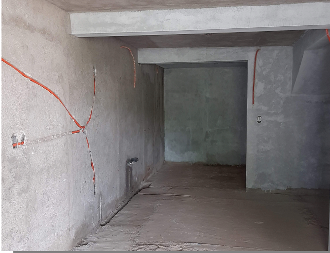
IMG-040 - Obra Gris 1
