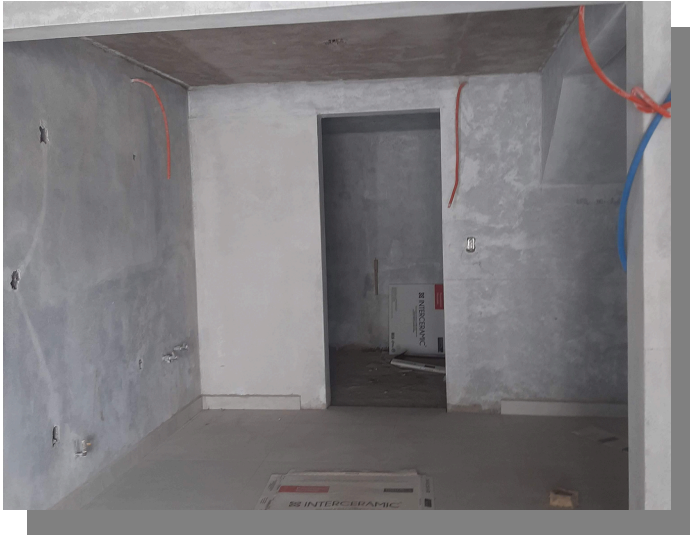
IMG-044 - Obra Blanca 1
