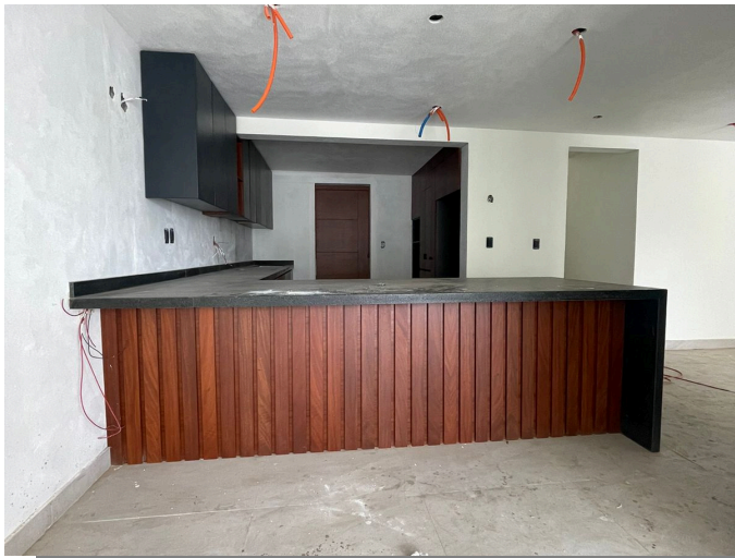
IMG-050 - Obra Blanca 7
