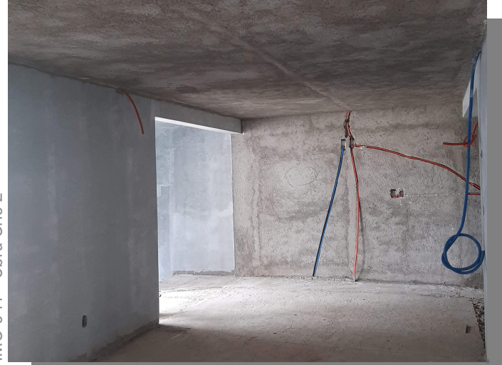
IMG-041 - Obra Gris 2
