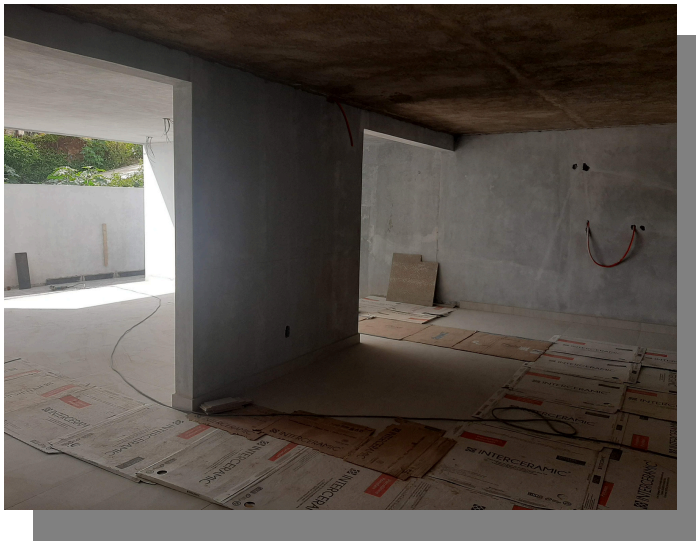
IMG-046 - Obra Blanca 3
