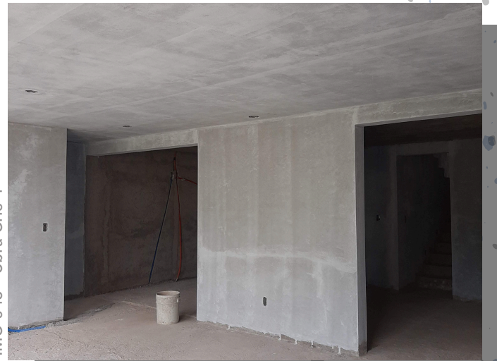
IMG-043 - Obra Gris 4
