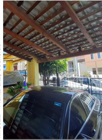
IMG022 - Planta alta, Cocheras
