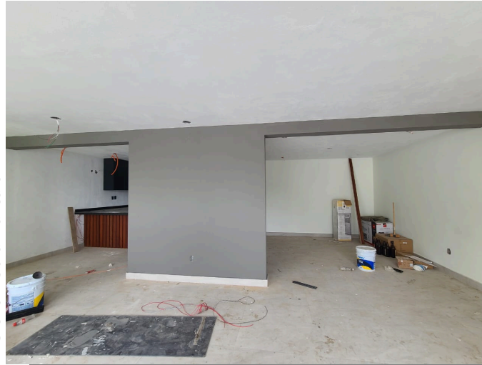
IMG-049 - Obra Blanca 6
