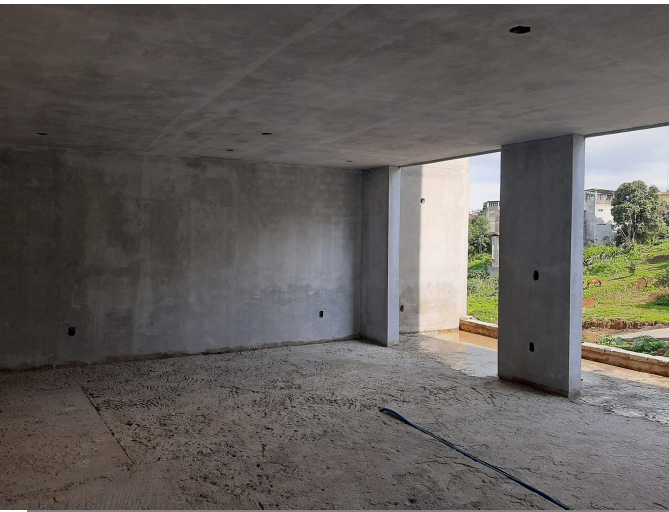
IMG-042 - Obra Gris 3
