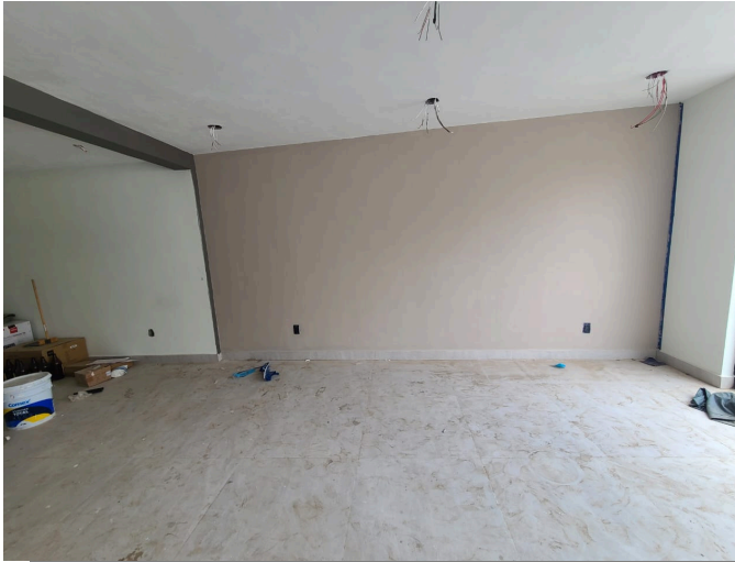
IMG-048 - Obra Blanca 5
