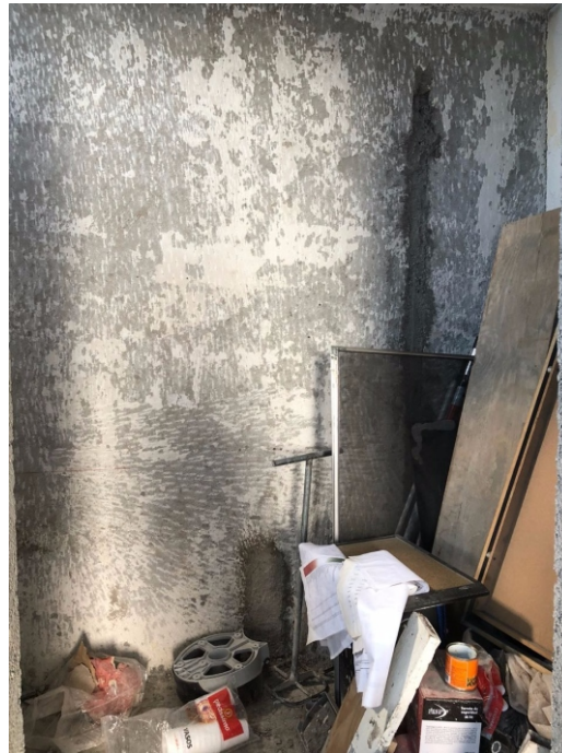
Fig. 173. Dirección administrativa, sanitario. Recuperado de archivo personal GHM
