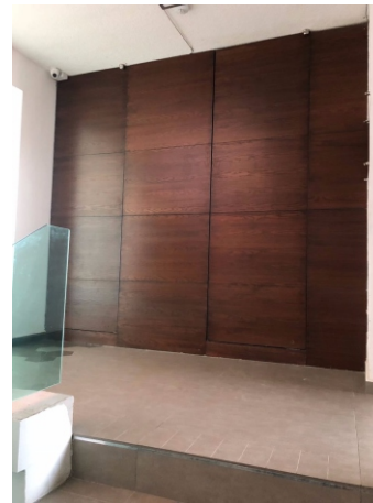
Fig. 159. Papelería y cuarto de instalaciones 3er nivel. Recuperado de archivo personal GHM
