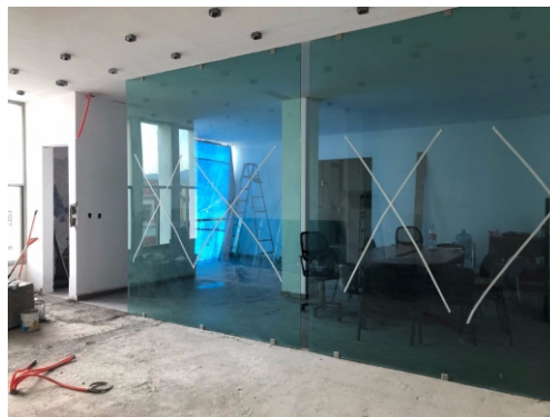
Fig. 156. Sala de juntas. Recuperado de archivo personal GHM
