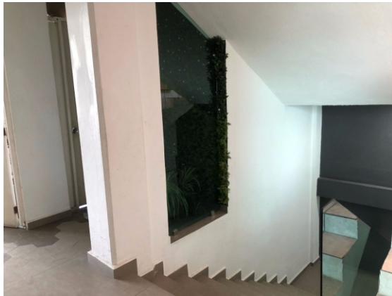
Fig. 158. Escaleras 3er nivel. Recuperado de archivo personal GHM
