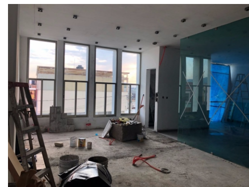
Fig. 157. Vista sala de juntas. Recuperado de archivo personal GHM
