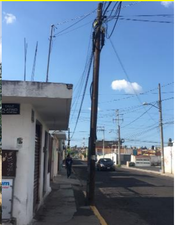
Imagen 4.45. Servicio de Teléfono
