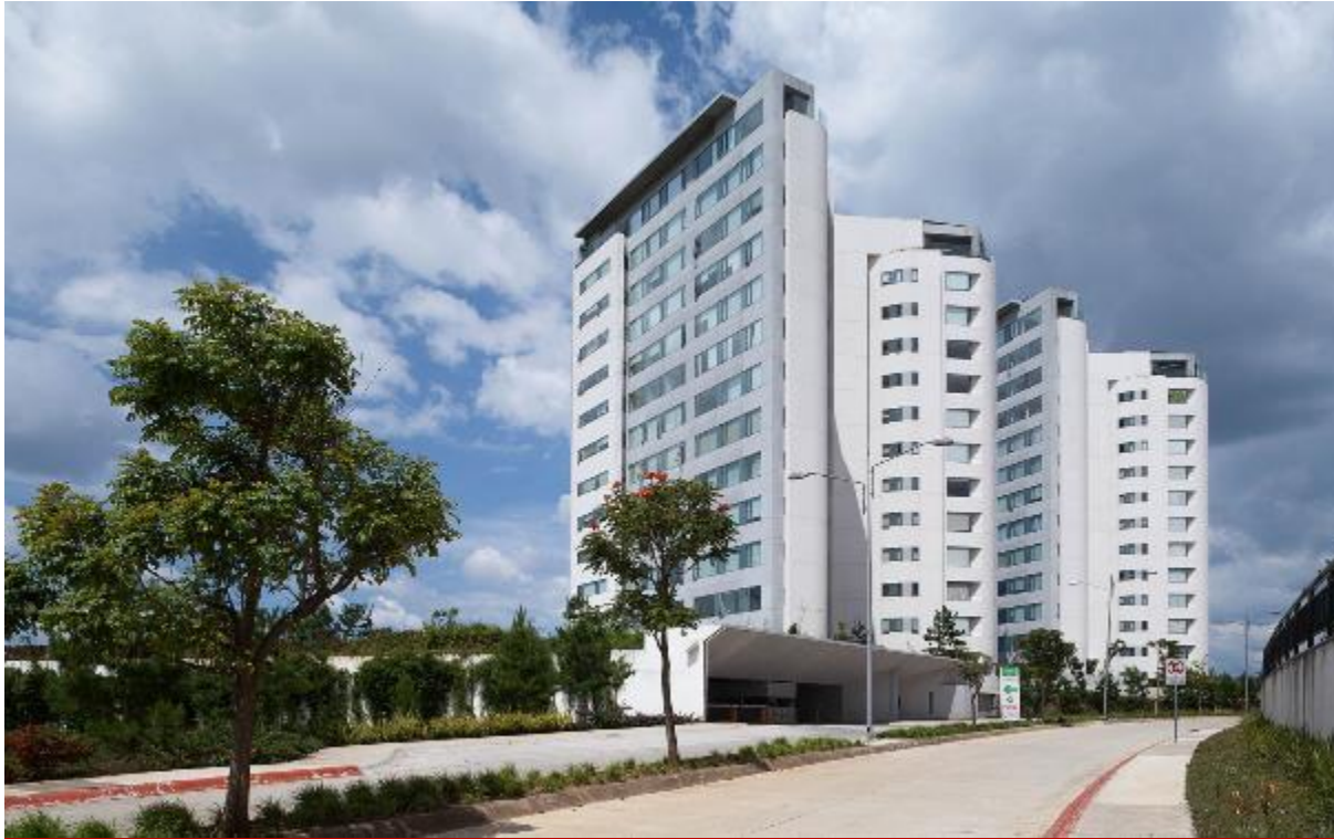
Imagen 1.78. Vista Exterior del Complejo.
