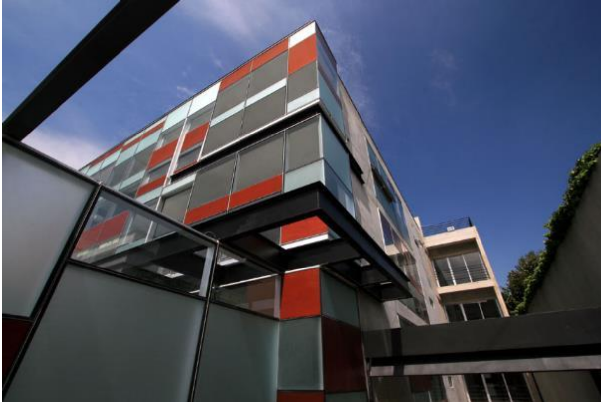
Imagen 1.67. Vista Exterior del Edificio.
