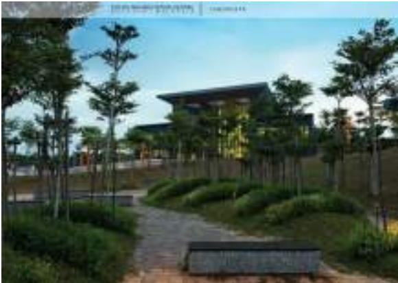
Ilustración 34 vista al edificio administrativo
