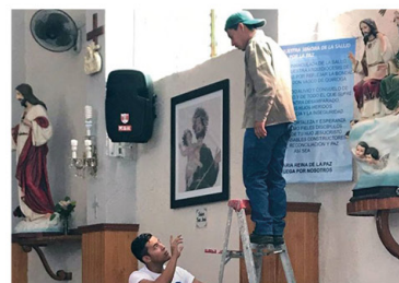
Se dio mantenimiento a un templo.
