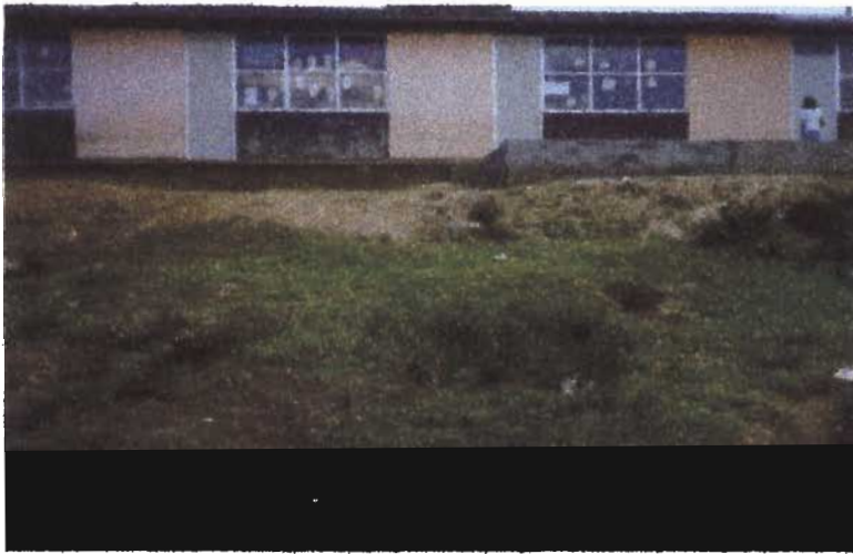
Escuela Primaria con que cuenta la colonia Vista Bella.
