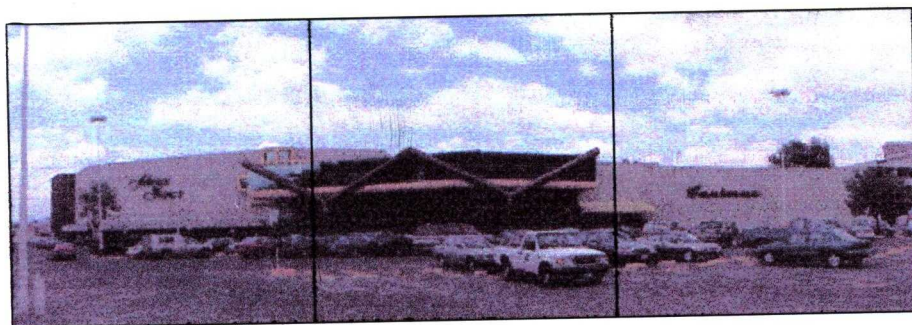
1. ÁREA DE ESTACIONAMIENTO SOBRE LA AVENIDA CAMELINAS COMO PRIMER CONTACTO ENTRE LA CALLE Y EL CENTRO COMERCIAL
