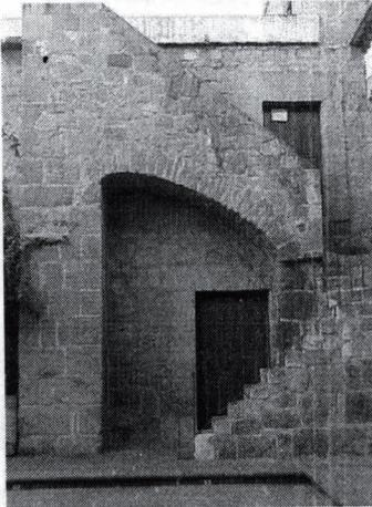
*Fig. 34. Arco irregular formado por la rampa de escalera, enmarcando un vano puerta en el patio posterior.*
