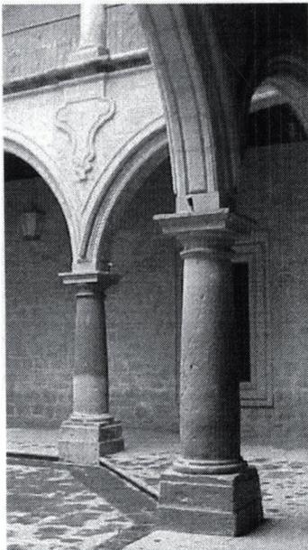
*Fig. 25. Columnas toscanas monolíticas con elementos de cantería, basa rectangular, fuste monolítico y capitel*
