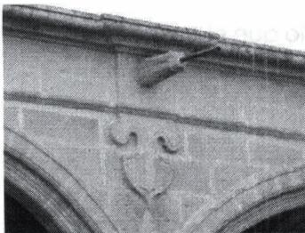
*Fig. 47. Guardamalleta, gárgola y cornisamiento moldurado, nivel de planta alta patio principal.*
