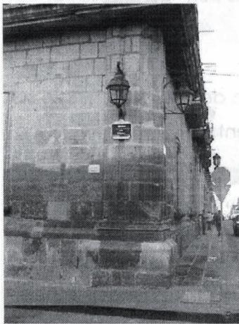
*Fig. 11. Contrafuerte, nivel planta baja fachada Norte y oriente.*
