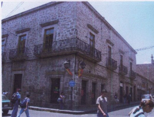
Esquina de Corregidora y Abasolo.
