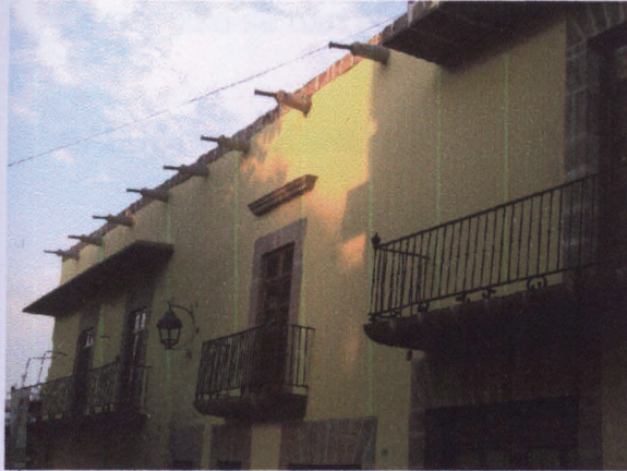
"Museo del Estado". Fachada Oeste.
