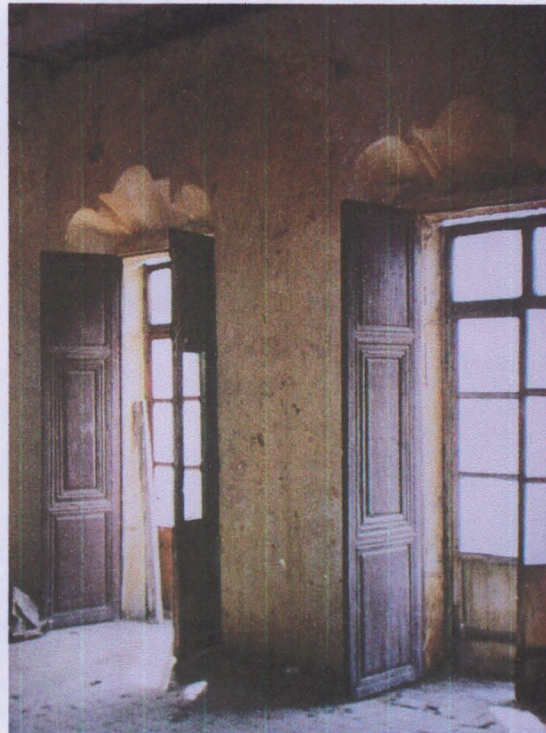
Ventanas con Capialzados en la habitación de la Planta Alta.
