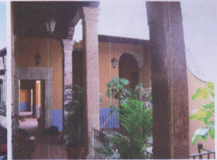
"Primer patio, segundo nivel, Vista hacia el Este"
