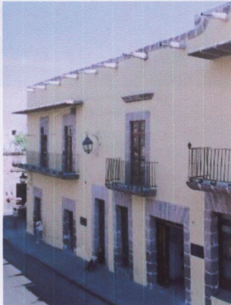
"Museo del Estado". Fachada Oeste
