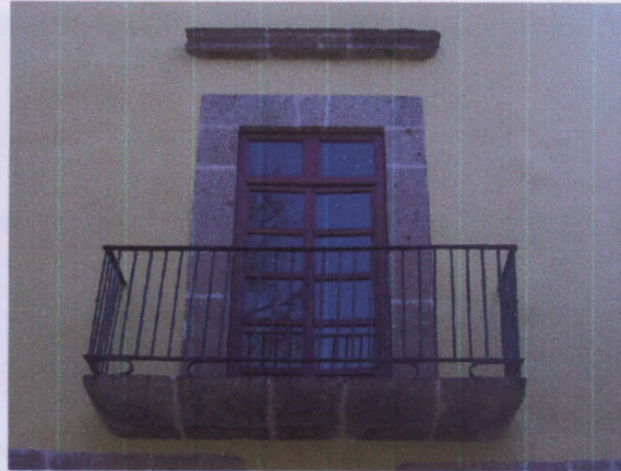
"Museo del Estado". Balcon en Fachada Oeste.
