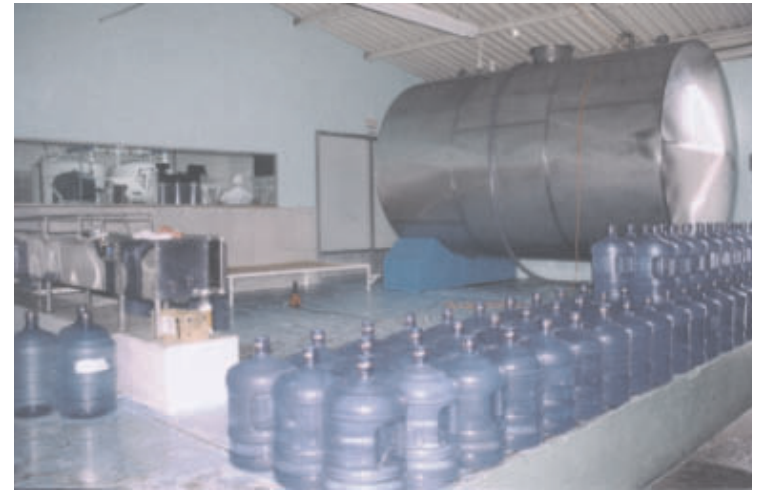
Instalaciones de la planta
