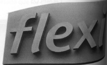
Logotipo Flexi en lamina de acero color arena, bajo relieve.
