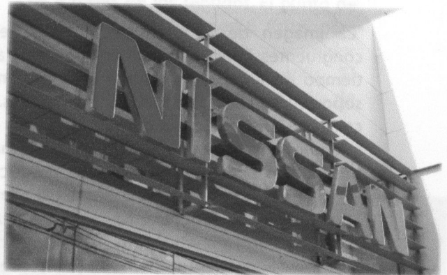
Este anuncio hecho con acrílico rojo y lámina color plata, la iluminación esta por dentro de cada letra, pues el acrílico respeta transparencias.
