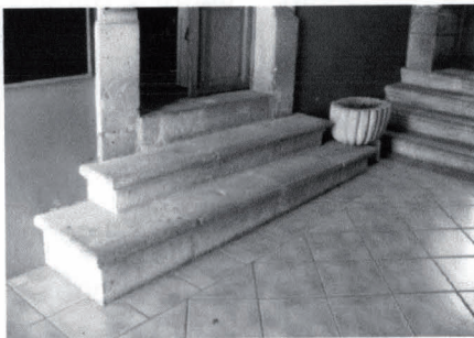
Fig. 25 Escalones en Vestíbulo
