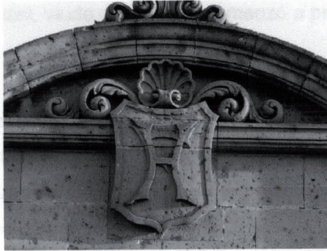
Fig. 5 Iniciales en Fachada
