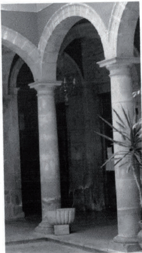
Fig. 22 Vista de Columnas
