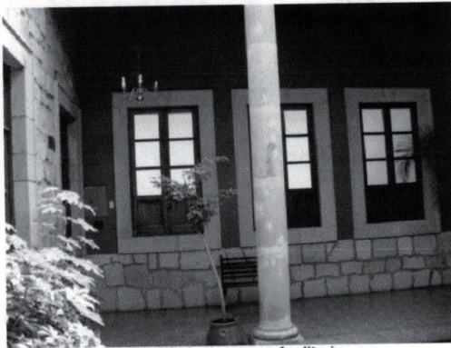
Fig. 19 Ventanas en Auditorio
