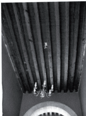
Fig. 23 Vista de Viguera en Techumbre
