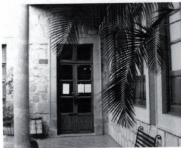
Fig. 20 Vano de Puerta en Segundo Patio
