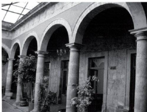
Fig. 16 Arquería en Primer Patio
