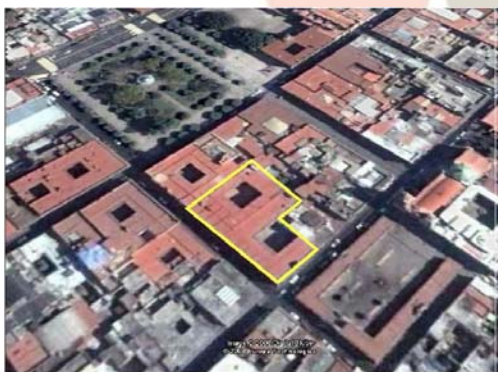
VISTA AEREA DEL EDIFICIO
