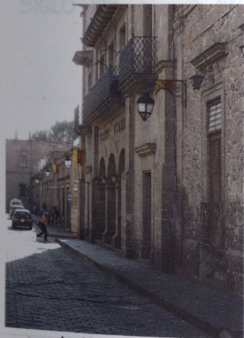
Actual fachada Teatro Ocampo
