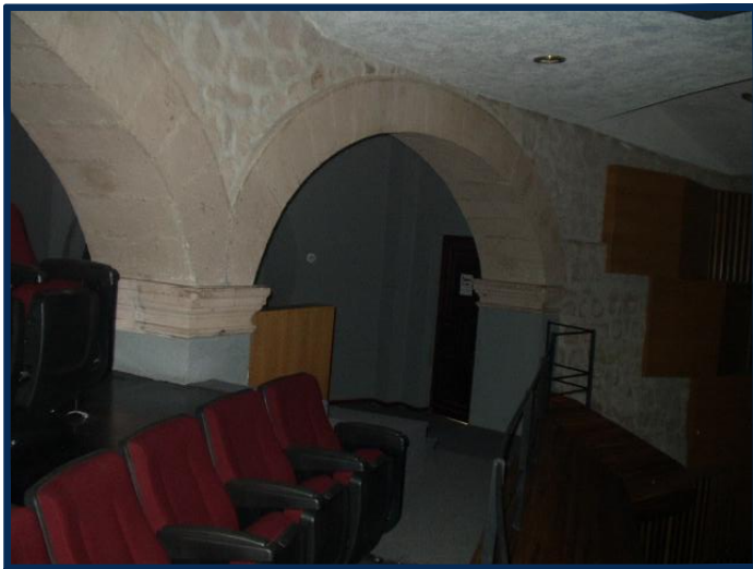
FOTO_17 (sala tercer nivel)
