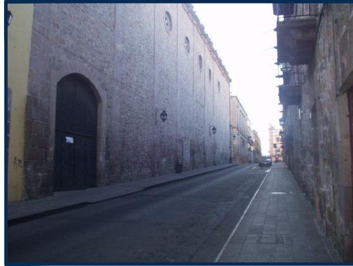
FOTO_3 (fachada lateral)
