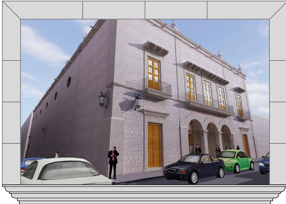
VISTA FACHADA LATERAL Y PRINCIPAL
