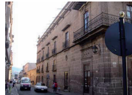
24.- Fachada este, mostrando las tres líneas de vanos.
