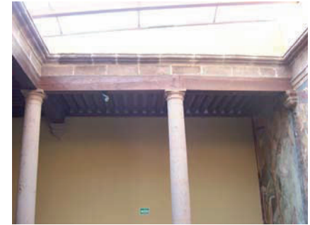
35.- Pretil, vista interior en el patio secundario.
