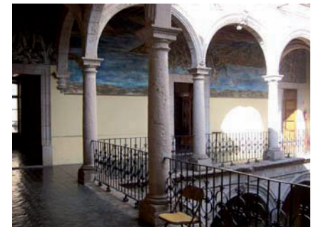
32.- Pasillo norte del patio principal en planta alta.
