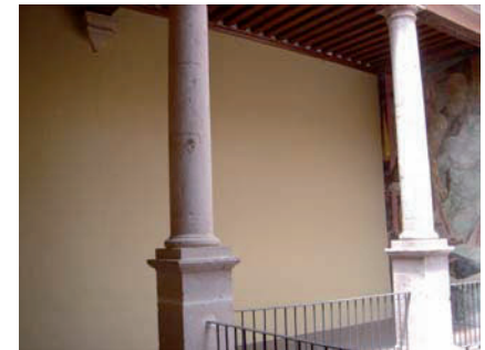
36.- Pasillo oeste del patio secundario en planta alta.
