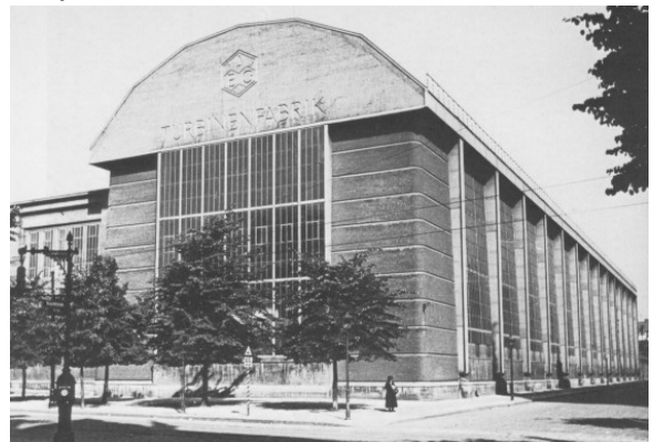
Fig. 18.9 La Turbinehalle della AEG (Berlino).
