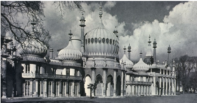
Fig. 16.33 El Pabellón real en Brighton.
