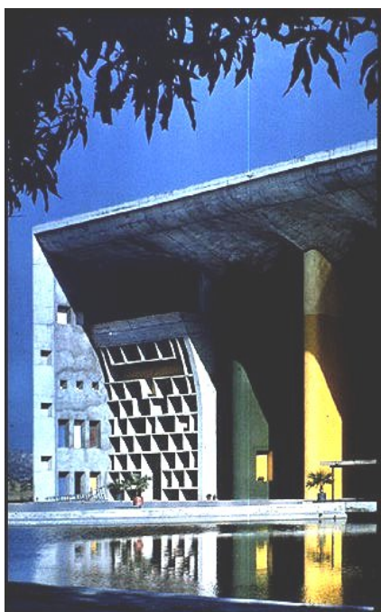
Fig. 19.39 Il Palazzo di Giustizia di Chandigarh.
