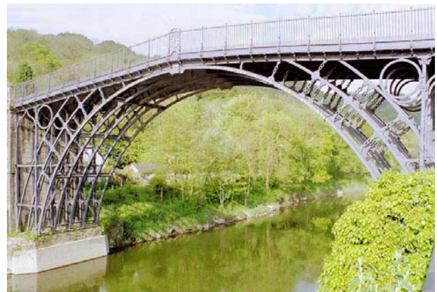
Fig. 17.1 El Puente de Coalbrookdale sobre el Río Severn.
