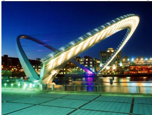
Fig. 21.5 El Thyne Millennium Bridge en Gateshead (Chris Wilkinson).
