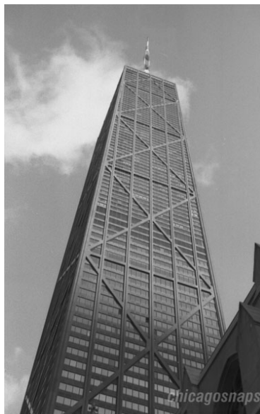
Fig. 20.15 Il John Hancock Center a Chicago.
