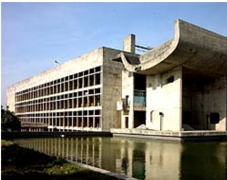
Fig. 19.38 El Palacio del Secretariado en Chandigarh.
