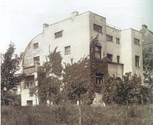
Fig. 18.14 Casa steiner (Viena).
