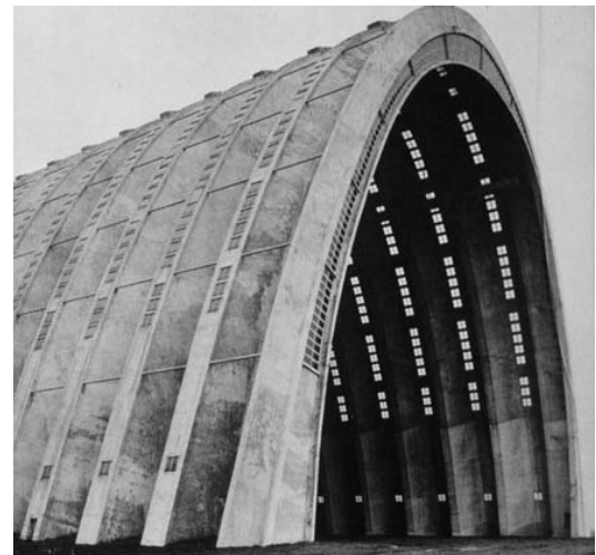
Fig. 19.11 El Hangar para Dirigibles en Orly.
