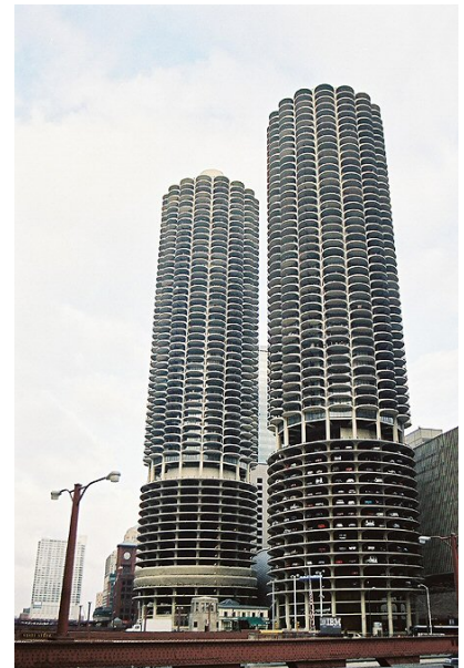
Fig. 20.12 Las Marine Towers de Chicago.
