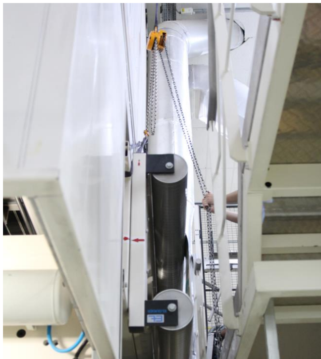
Ilustración 12 Desmontaje de alineador de entrada usando polipasto manual.
