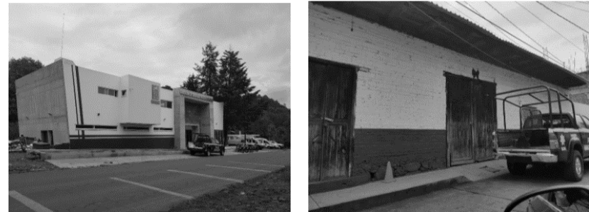
IMAGEN 2: CONDICIONES ACTUALES ESTACIONES DE POLICIA MUNICIPAL TANCÍTARO 2019
