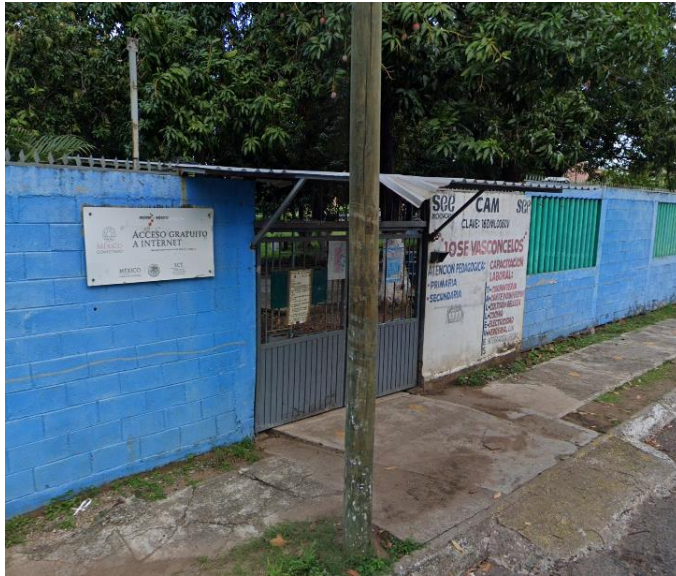
Ilustración 59. Fachada principal CAM laboral Lázaro Cárdena, fotografía propia
