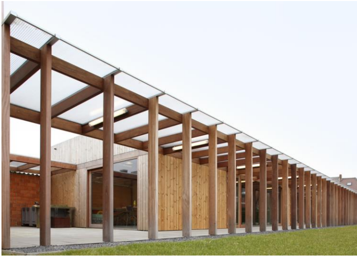
Ilustración 29. Edificio Ondersteuningscentrum Omega
