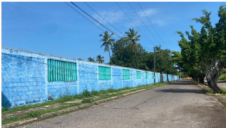
Ilustración 61. Barda perimetral CAM laboral Lázaro Cárdenas, fotografía propia
