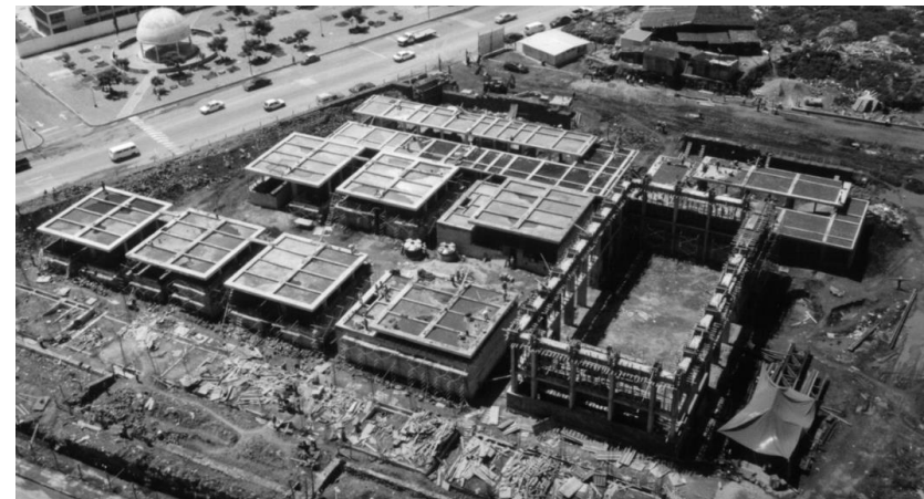
Ilustración 49. Proceso constructivo Centro de invidentes y débiles visuales fotografía por: Taller Mauricio Rocha
