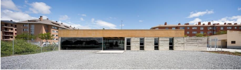
Ilustración 34. Edificio de ASPAYM-Ávila, España
