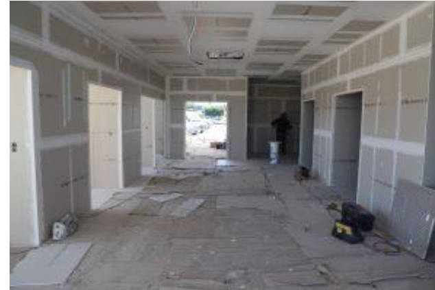
Ilustración 57. Sistema constructivo del ISIPD fotografía por Gobierno de Baja California Sur
