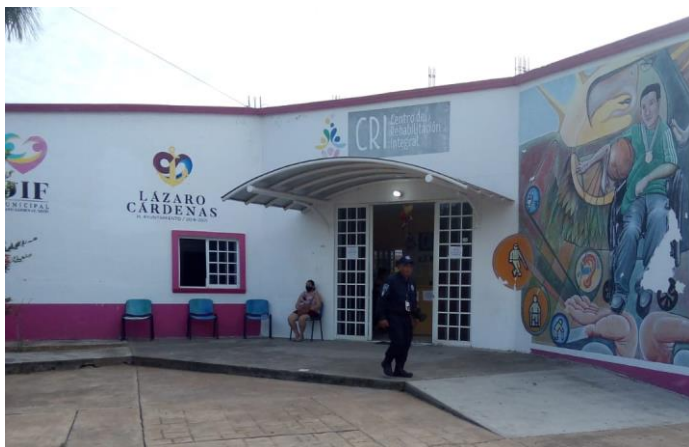
Ilustración 96. Fotografía del exterior del centro de rehabilitación Lázaro Cárdenas
