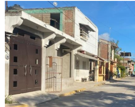
Ilustración 185. Fotografía propia de Viviendas adosadas a la calle
