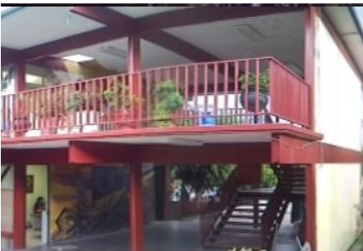
Imagen 81. Detalle de edificio de aulas.
