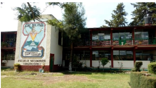
Imagen 142. Edificio de aulas.
