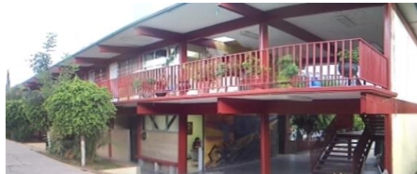
Imagen 76. Edificio de aulas.
