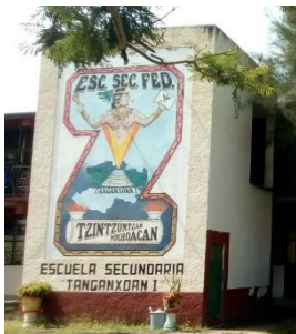
Imagen 134. Mural en edificio de aulas.
