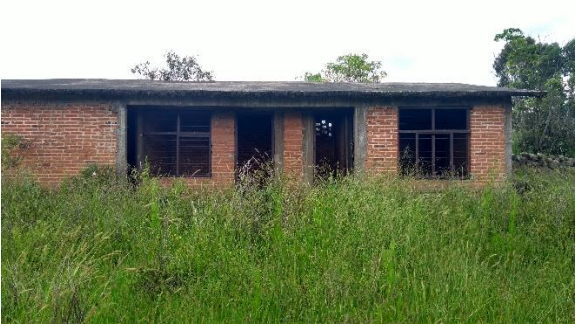
F14. En esta fotografía se observa la construcción que existe dentro del terreno, es una construcción a base de tabique.
