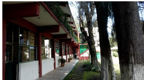
Imagen 143. Detalle de edificio de aulas.
