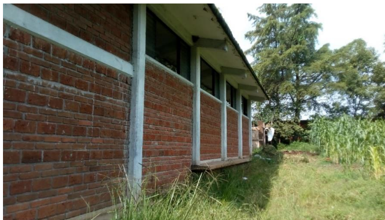
Imagen 128. Detalle de construcción de aulas.
