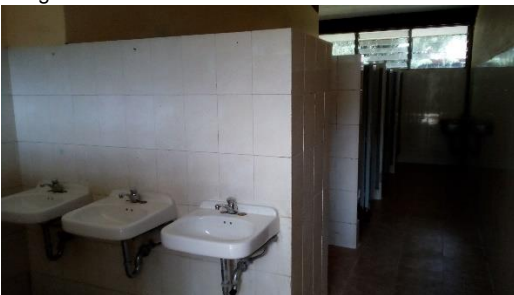
Imagen 106. Sanitarios de hombres.
