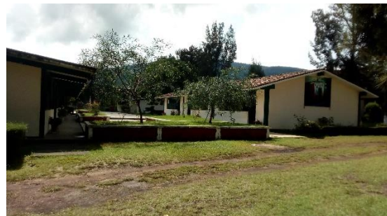
Imagen 141. Naves de aulas y jardines.
