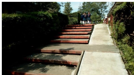
Imagen 126. Escaleras y rampa.
