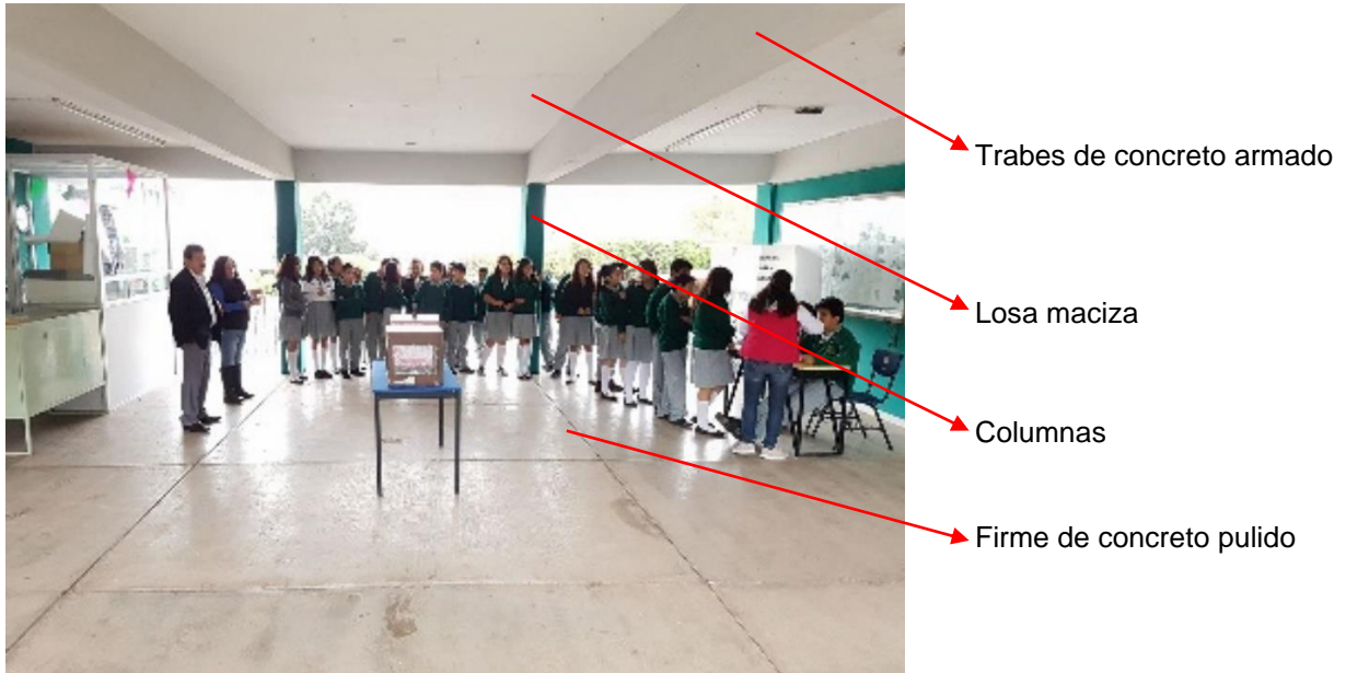
Imagen 96. Interior de edificio de aulas.
