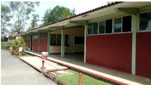
Imagen 121. Nave de aulas.
