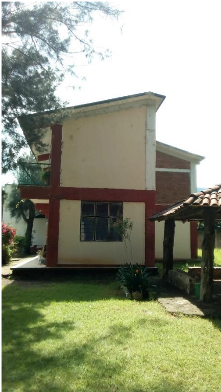
Imagen 148. Vista lateral de edificio de aulas.
