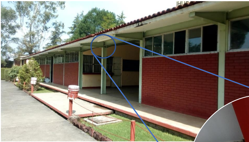
Imagen 129. Nave de aulas.
