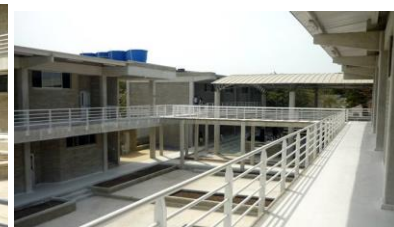
Imagen 24. Edificio de aulas 2, colegio distrital.
