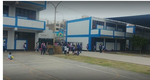
Imagen 38. Edificios de aulas y área vestibular.
