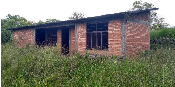
F1. Construcción dentro del terreno.
