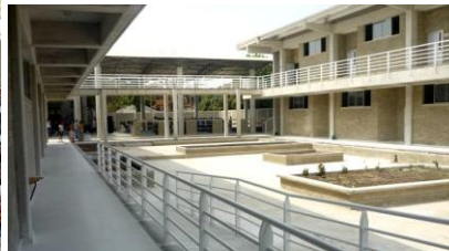
Imagen 23. Edificio de aulas, colegio distrital.
