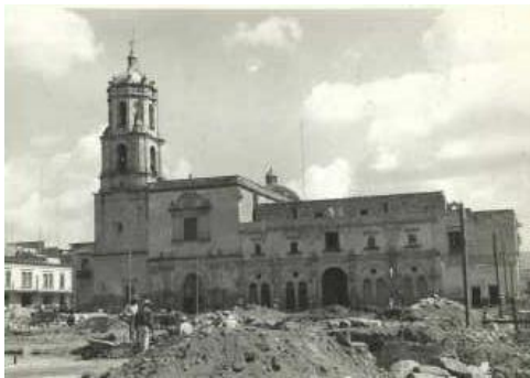
Figura 19 Excavación para la construcción de la Plaza (Carlos)
