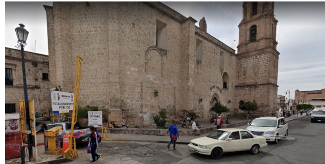
Figura 8 Actual calle Bartolomé de las Casas, demoliendo completamente el edificio junto al templo, dejando una abertura en el templo para acceso. (Google, 2021)
