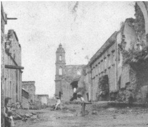
Figura 9 Demolición del templo de la tercera orden franciscana (Espejel, Michoacán histórico, 2016)
