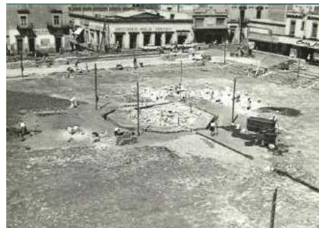
Figura 20 Vista aérea del proceso de la construcción de la plaza (Carlos)
