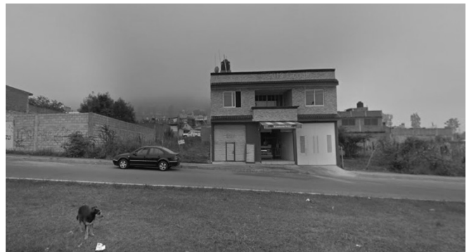
Ilustración 25- Estado actual 2 (fuente: de autor)
