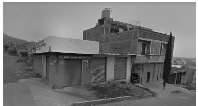
Ilustración 27- Estado actual 3 (fuente: de autor)
