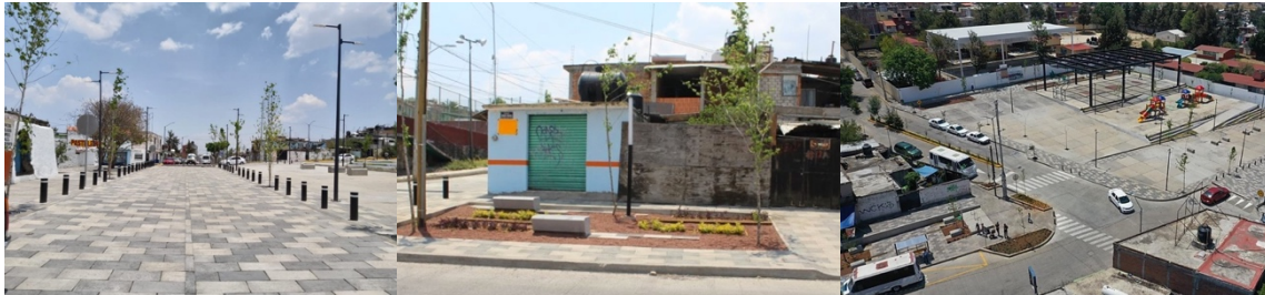
Ilustración 5- Remodelación Toma de Oaxaca (fuente: desconocido. (2020). Gobierno de Morelia, por concluir obras en las Trincheras de Morelos. Agosto 2020, de MiMorelia.com Sitio web: https://www.mimorelia.com/gobierno-de-morelia-por-concluir-obras-en-las-trincheras-de-morelos/
