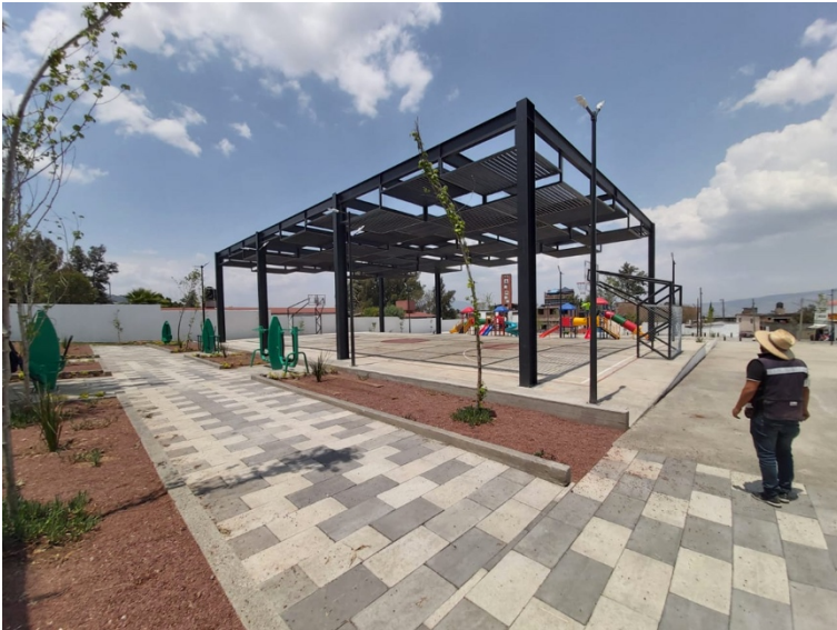
Ilustración 7- Remodelación toma de Oaxaca I (fuente: Román Meyer Falcón https://twitter.com/MeyerFalcon/status/1271550647167574016 )
