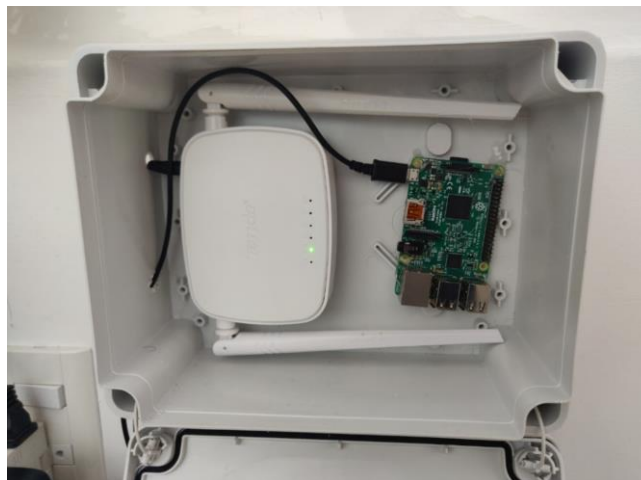
Figura 2.52 Caja de control
