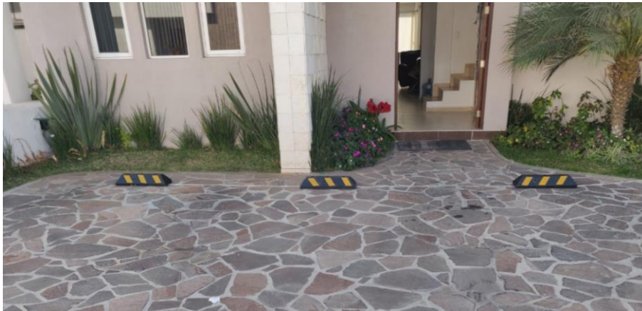
Figura 2.55 Topes 1, 2 y 3 instalados y funcionando
