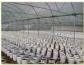
Este tipo de invernaderos tienen su origen en los invernaderos-túneles. Por lo común son de tipo metálicos (caños de 2" a 2,5" de diámetro o bien perfiles triangulares con hierro redondo trefilado de 8-10 mm de diámetro), también hay con techumbres metálicas y postes de madera.
