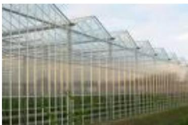
Son invernaderos de vidrio, los paneles descansan sobre los canales de recogida del agua pluvial. La anchura de cada módulo es de 3,2 m y la separación entre postes en el sentido longitudinal es de 3 m.
