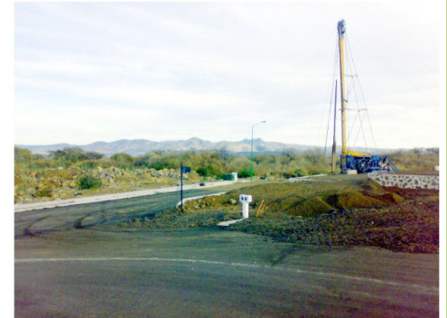
Imagen 110 : Pavimentación en las calles
