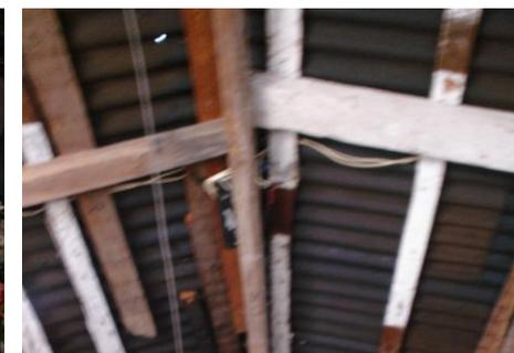
FOTO NO. 8. TECHO INTERIOR DE MADERA Y LÁMINA DE ASBESTO
