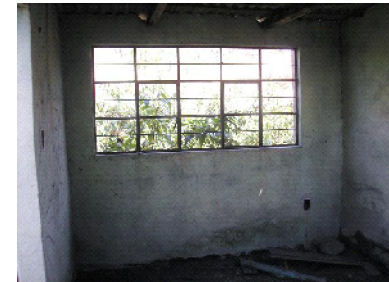
FIG. 64 Falta de vidrio en la ventana de herrero Presenta grietas en el altoparlado Incuria Filtraciones
