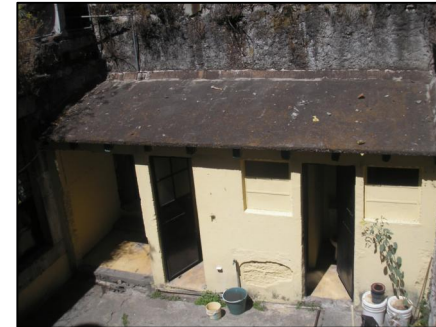
FIG. 29 Cestra negra "Azucarado" Desprendimiento de piso en drenaje materia en piso Hicofora en muro, techumbre
