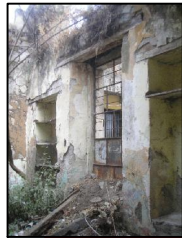
FIG. 30 Desprendimiento de aplastado Alteración ventana de herrería oxidada Presencia vegetal de raíces y árboles
