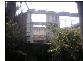
FIG. 86 Cubierta fracturada Filtración
