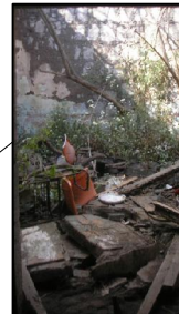
FIG. 32 Desprendimiento de aplastado Abandono
