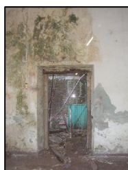
FIG. 7 Filtración por humedad
