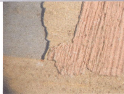
Fig.4. variedad de colores de pintura a la cal.
