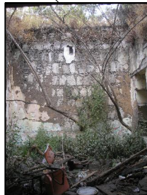
FIG. 31 Muros dañados Presencia de raíces de árboles y arbustos
