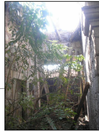
FIG. 6 Cubierta colapsada Presencia vegetal
