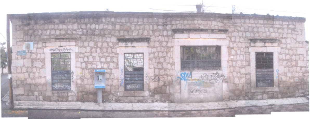
Fig. 1 Fachada principal (Poniente.)
