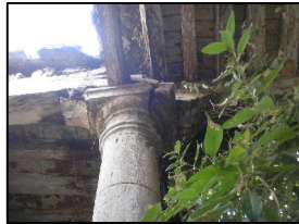
FIG. 50 capital fracturado Crisas y viguería en peores condiciones Presencia de vegetación
