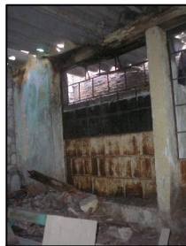
FDE. 23 Ventanas de Hierro con oxidación
