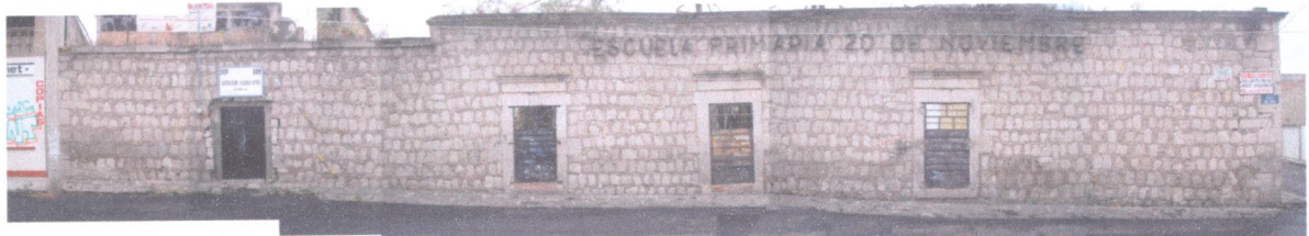
Fig. 2 Fachada lateral (Norte)
