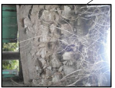
FIG. 40 Punto estructural Presencia de raíces en muro Daño de la puerta ya vendida
