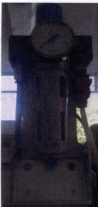
**Ilustración 15 Válvula de cierre con filtro regulador**
