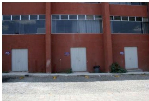
Ilustración 4.2 Talleres de Carpintería, herrería y maquetas en el edificio D.
