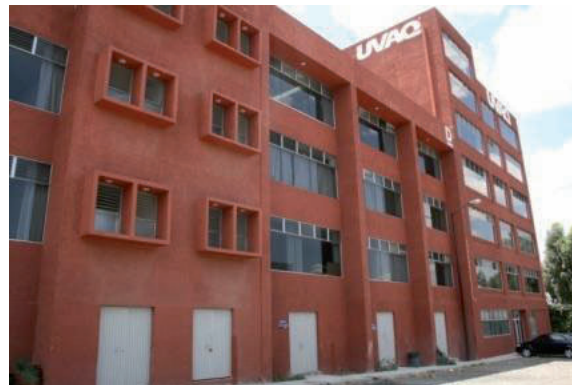
Ilustración 4.1 Espaldas del edificio D.
