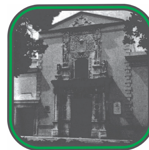
Las construcciones civiles edificadas y habitadas por los capitanes españoles, denotaban la nostalgia por su tierra natal.
