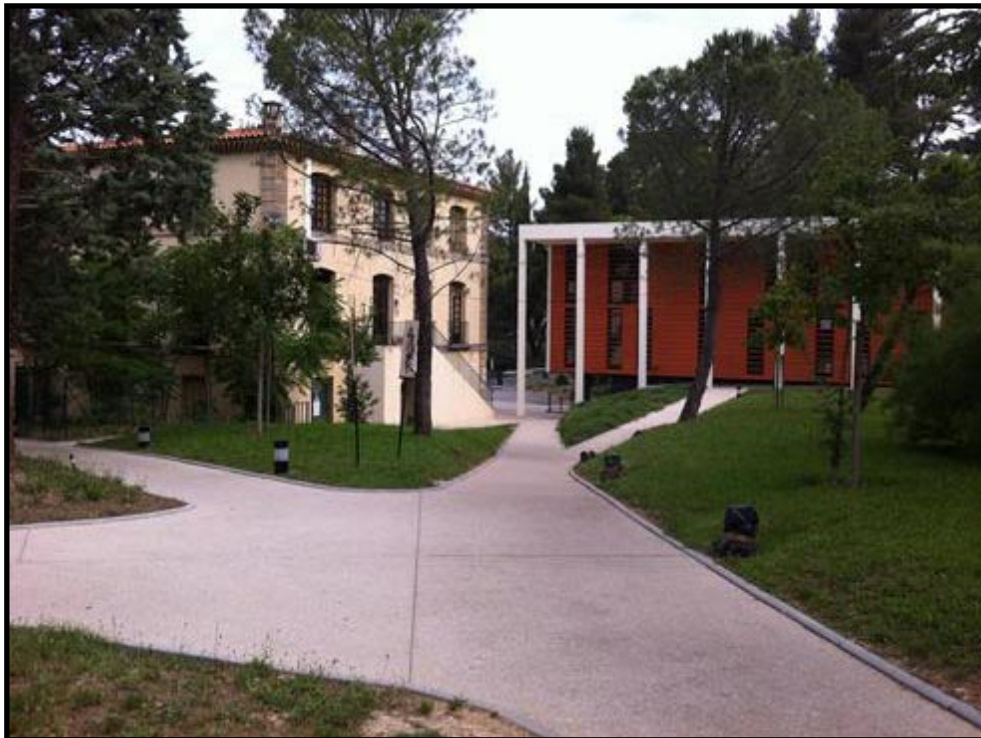
Ilustración 25. Detalle del edificio de administración regional del CROUS de la residencia de Aix-en-Provence. Archivo personal.
