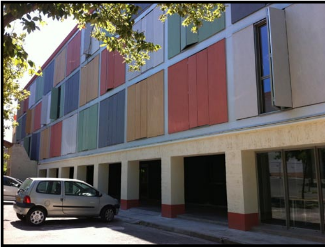
Ilustración 23. Detalle del exterior del pabellón 1 de la residencia de Aix-en-Provence. Archivo personal.
