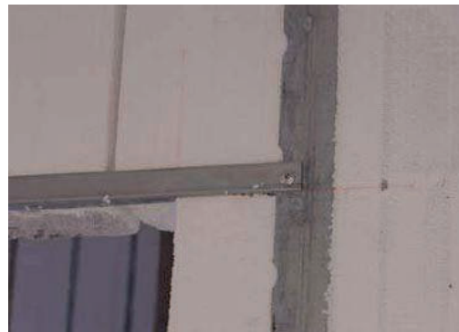
APLICACIÓN DE AISLANTE, INSTALACIONES, YESO.
