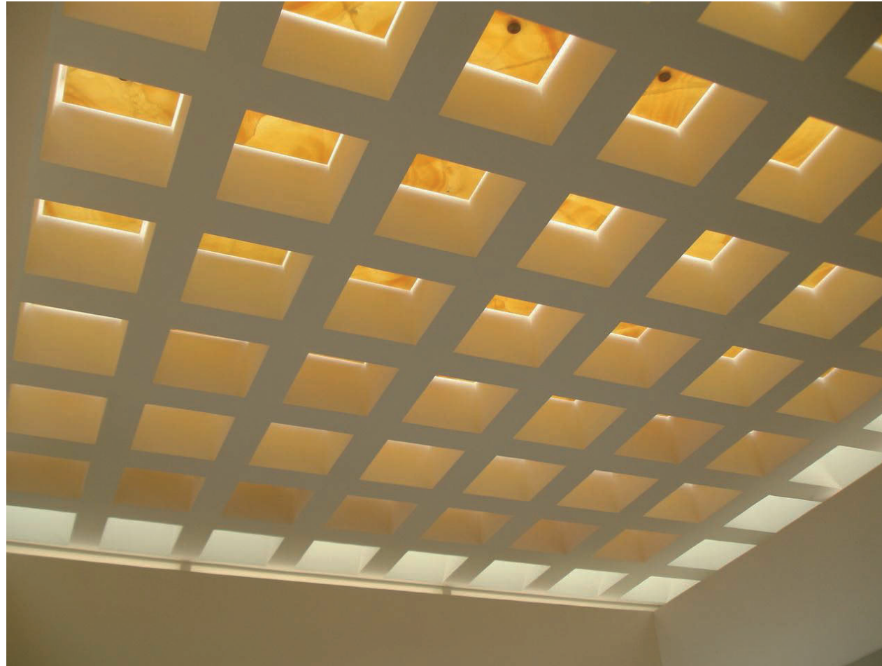
PERGOLADO EN PLAFÓN DE SALA TV
