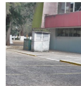
Fig. 36 ESTACIONAMIENTO POSTERIOR BFJM.
