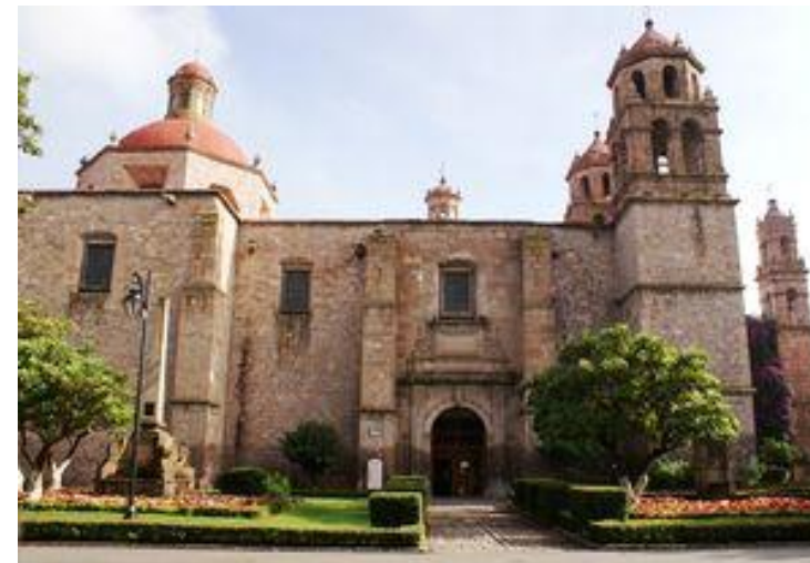
Fig. 4 FACHADA DE LA BIBLIOTECA PÚBLICA UMSNH.
