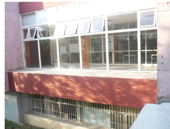
Fig. 59 VISTA FACHADA BFJM.
