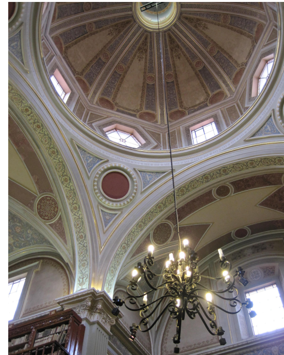
Fig. 9 ILUMINACIÓN BIBLIOTECA PÚBLICA UMSNH.
