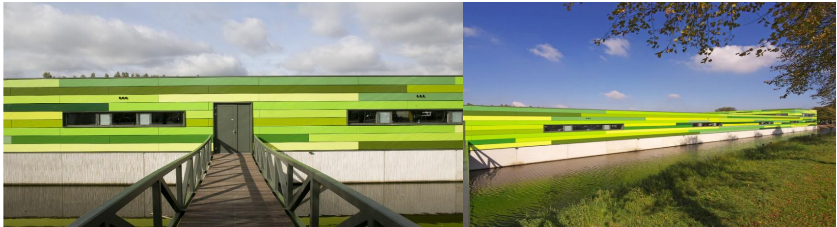
IMAGEN 43_ Acceso de servicio y colindancia del acceso del servicio
