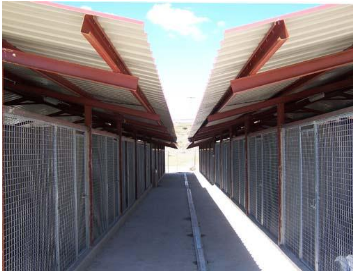
IMAGEN 87_ Pasillo Central a los compartimientos
