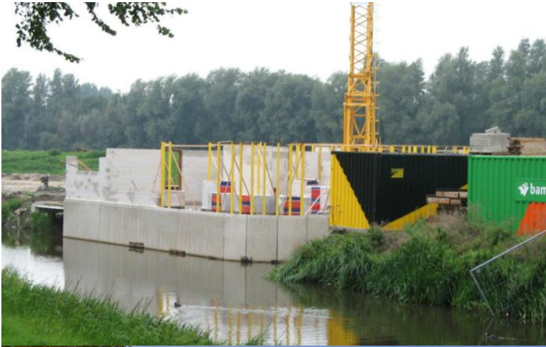
IMAGEN 39_ Construcción del edificio
