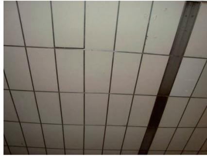
**Plafond modulado con estructura laminada en modulos de panel de yeso con acabado rugoso de 1x .60m que se encuentra en un estado deteriorado**
