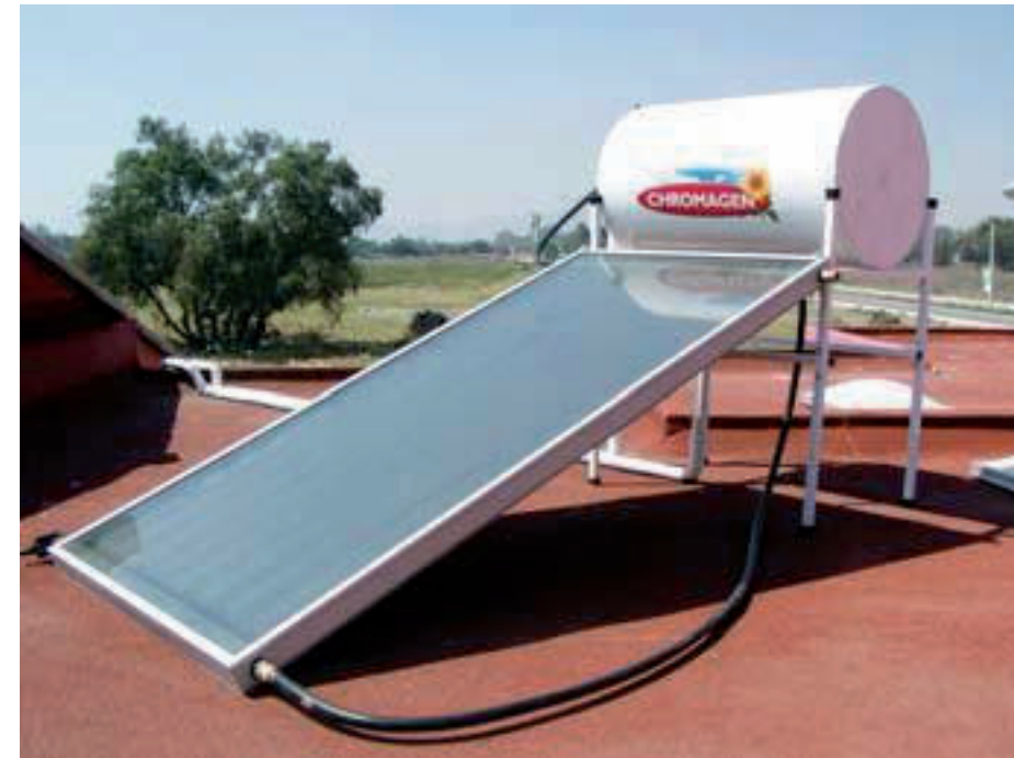
Imagen 33 Ejemplo de calentador solar por panel solar.
