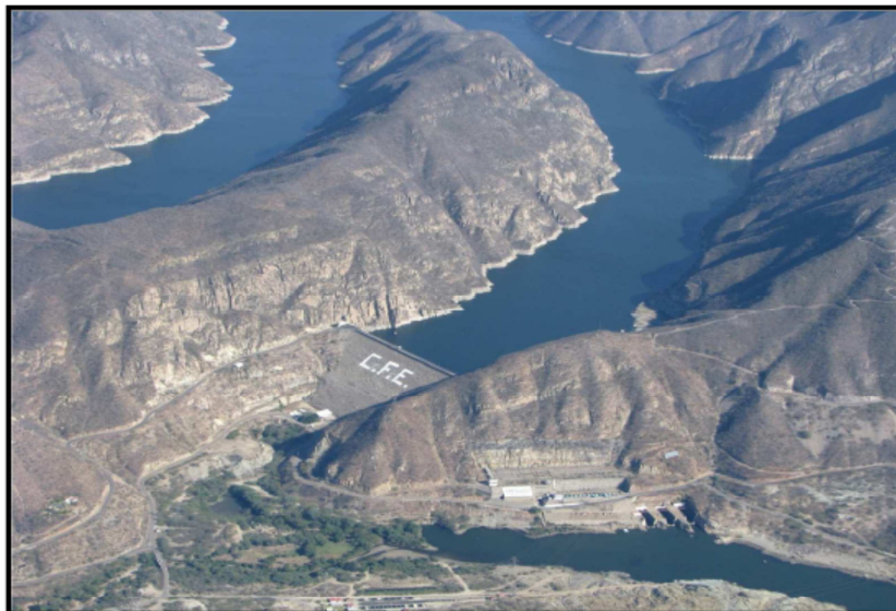
Central Hidroeléctrica Infiernillo
