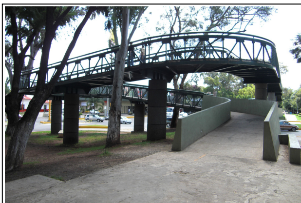
Ilustración 0194: JCCG: Puente de La Calzada (Tomado Enero 2006)
