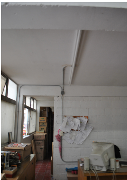
Imagen 66. Subida de cables de instalación eléctrica.
